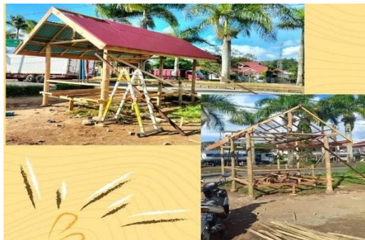
Gambar 1. Pembangunan Gazebo di Rumah Baca Anak Nagari (2022)
