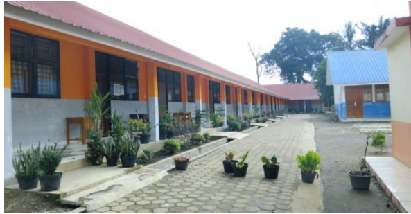
Gambar 1 Fasilitas sekolah MIS Kajai yang sudah dibangun kembali pasca bencana
