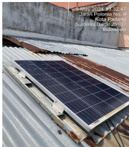
Gambar 2. Panel surya kemiringan 72^\circ
