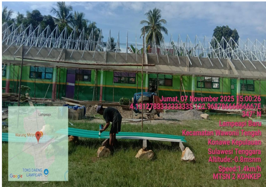
Gambar 2 Pekerjaan Rehabilitasi Madrasah di Kab. Konawe Kepulauan
