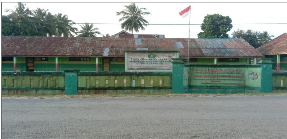
Gambar 1. Kondisi Bangunan MTs Sebelum Rehabilitasi di Kabupaten Konawe Kepulauan. Sumber : BPPW Sultra (2025)
