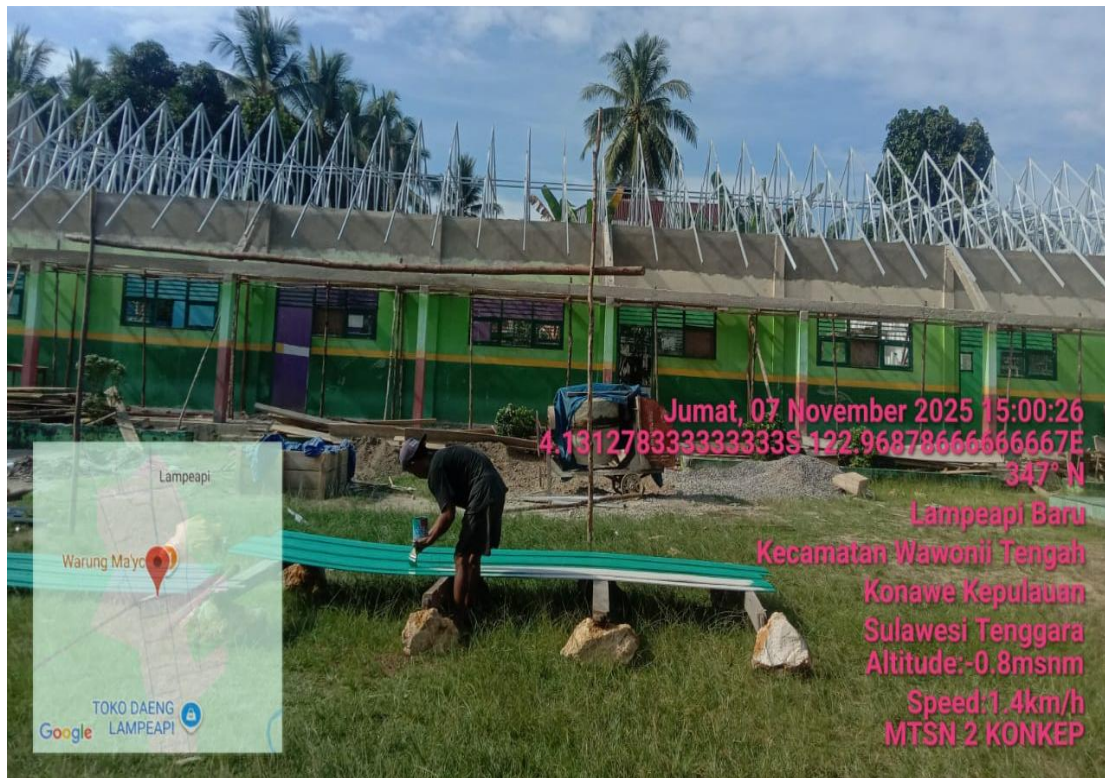
Gambar 2 Pekerjaan Rehabilitasi Madrasah di Kab. Konawe Kepulauan
