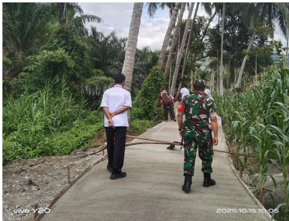
Gambar 2. Pembangunan Jalan Secara Bertahap
