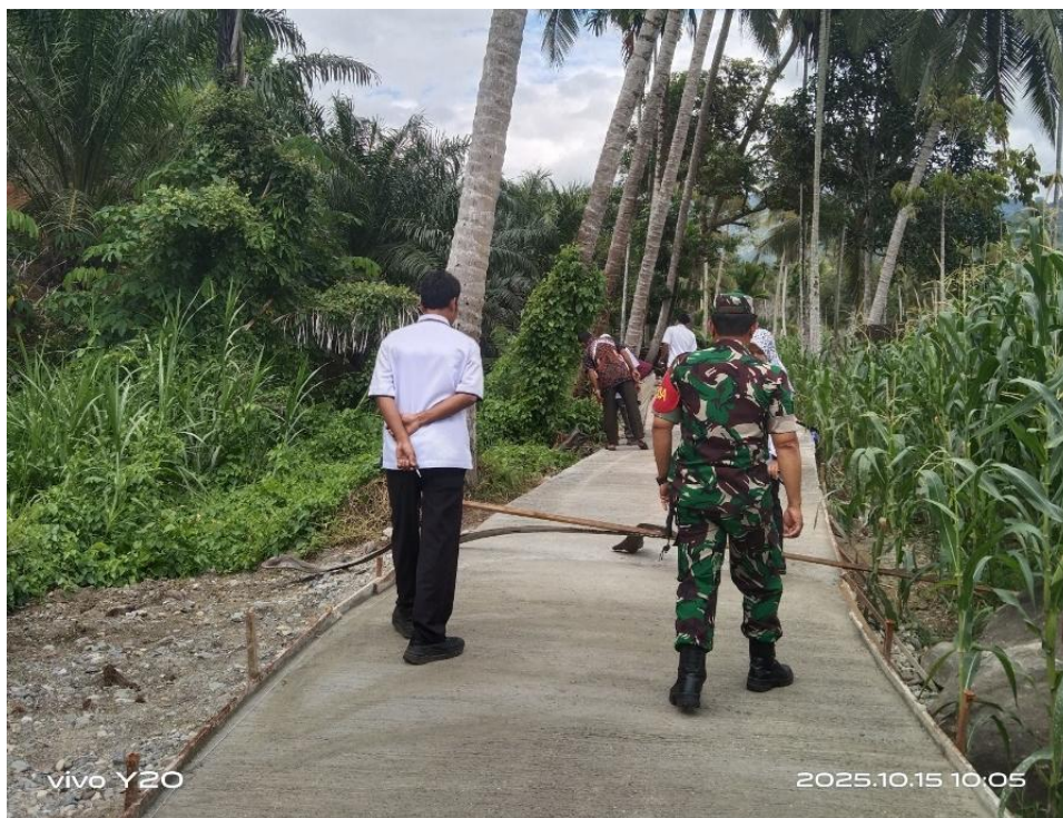
Gambar 2. Pembangunan Jalan Secara Bertahap
