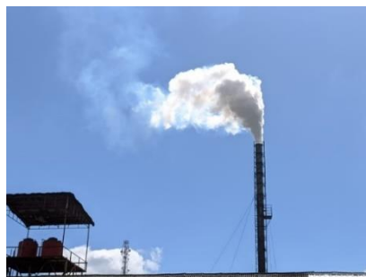
Gambar 1. Cerobong asap pabrik
