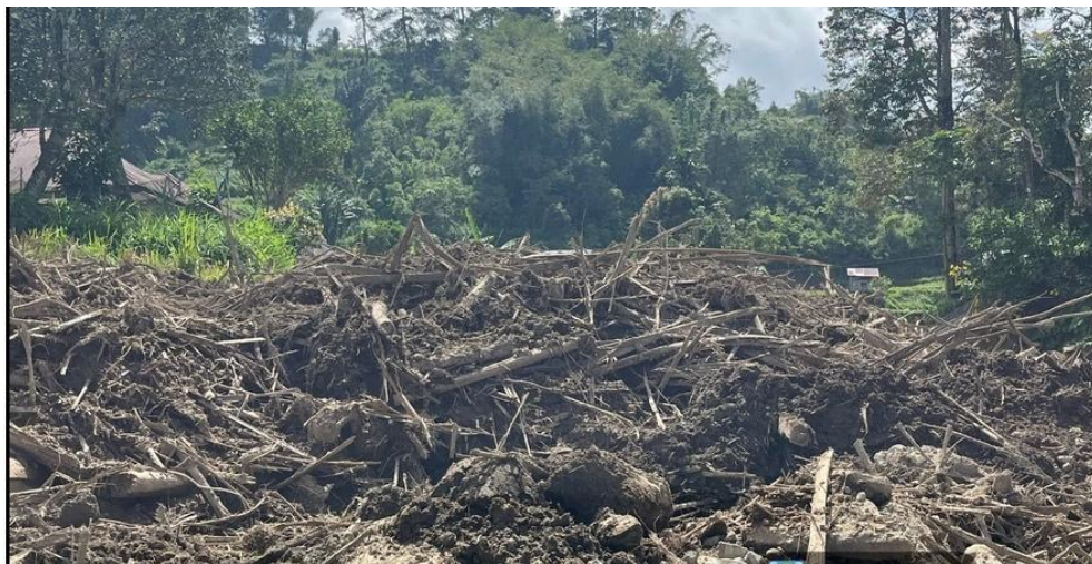
Gambar 1. Kerusakan Rumah dan Lingkungan Permukiman Akibat Bencana
